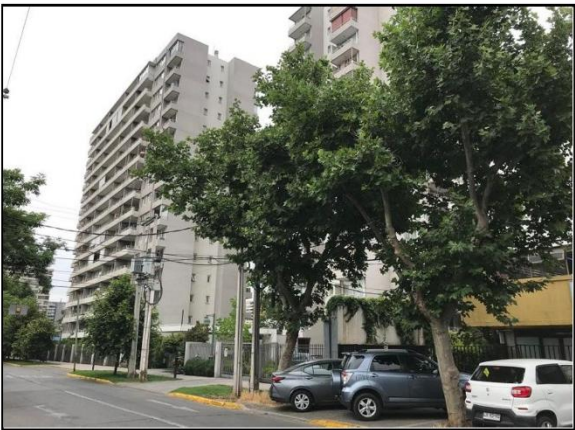
Fotografía N°4 del 07.11.2024: Entorno de la instalación.
