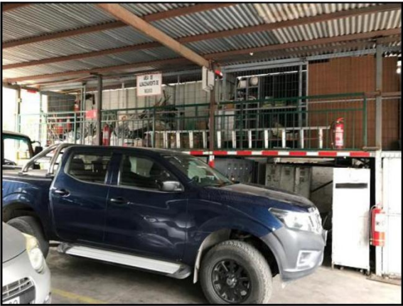
Fotografía N°1 del 07.11.2024: Interior de la instalación.
