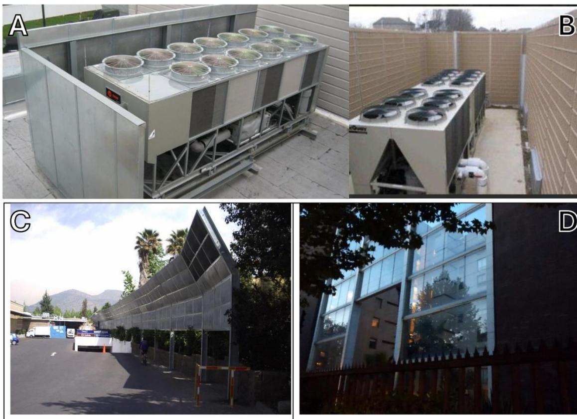
Fuente: Modificada desde Adenda excepcional, Anexo A "Ruido y vibraciones", Figuras 17 y 20, págs. 56 y 59. A) y B) Tipo de barreras acústicas a ser utilizadas en los equipos de climatización; C) y D) Tipo de barrera acústica a ser utilizada en patio de carga.
