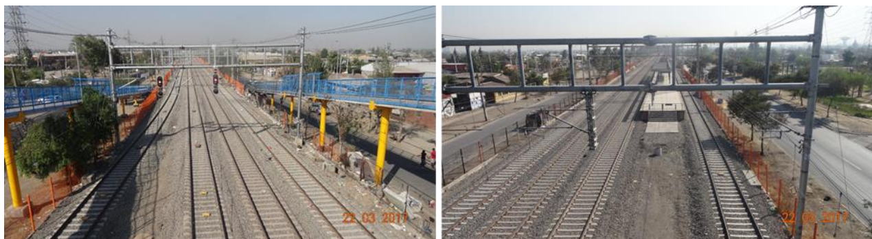
Figura N°4: Cierre y pasarela peatonal sobre nivel Salvador Allende
