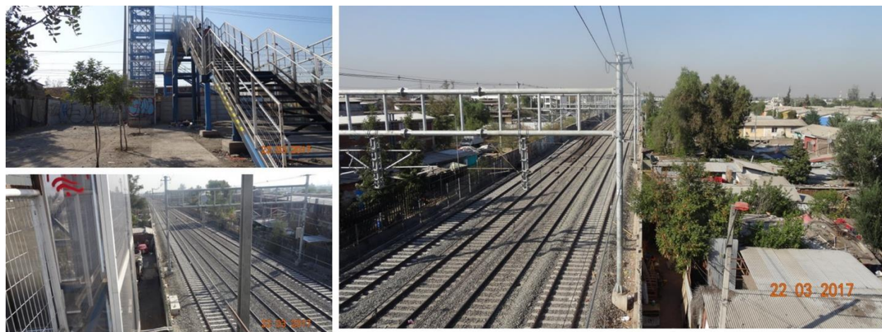
Figura N°6: Cierre y pasarela peatonal sobre nivel pasaje 6
