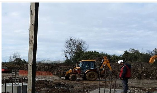
Fotografía 5. Maquinaria operando en la ejecución de obras de construcción en la unidad fiscalizable.
