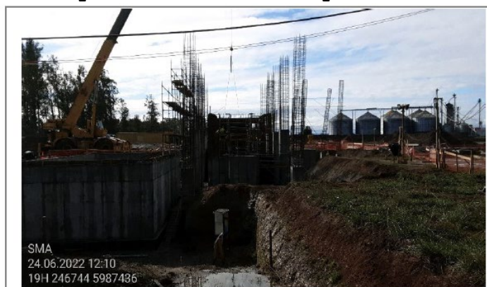
Fotografía 3. Bases y fundaciones de las edificaciones ejecutadas en la unidad fiscalizable.
