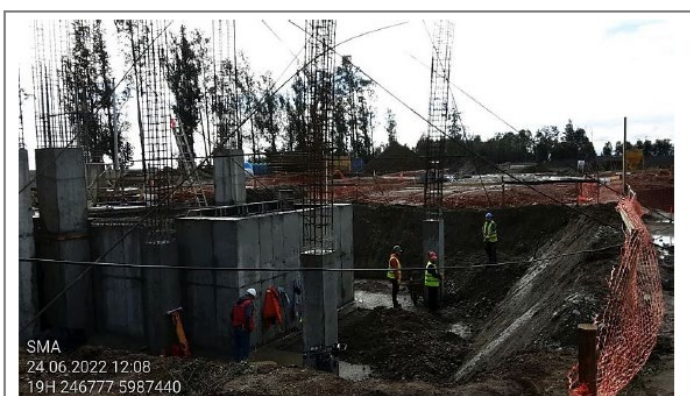
Fotografía 4. Bases y fundaciones de las edificaciones ejecutadas en la unidad fiscalizable.
