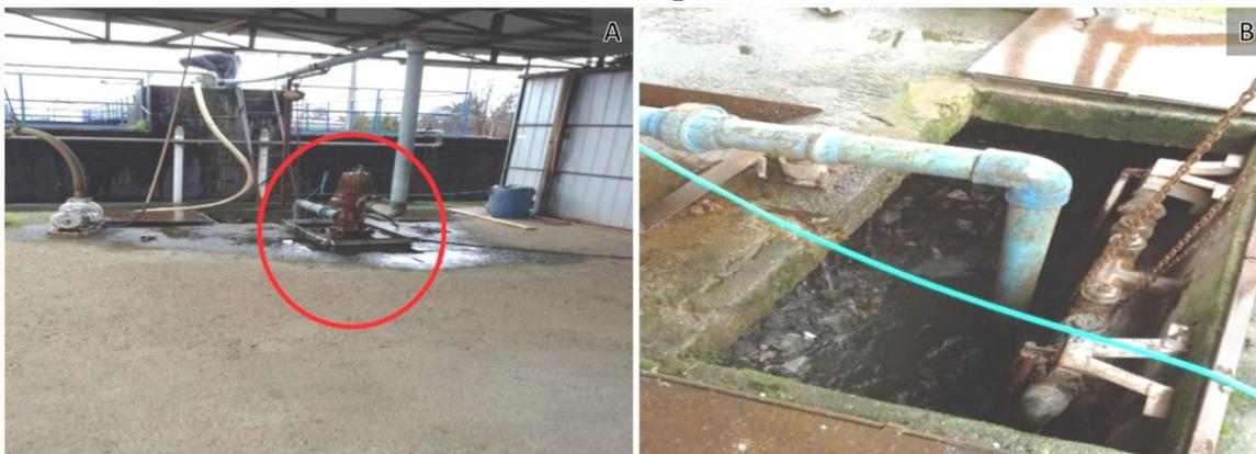
Fuente: Elaboración propia del Tribunal a partir de imágenes en el Expediente sancionatorio. A) Vista general con bomba elevadora (Fotografía 1, fs. 45); B) Vista de detalle piscina de llegada en la que se aprecian residuos sólidos flotando (Fotografía 4, fs. 45).
