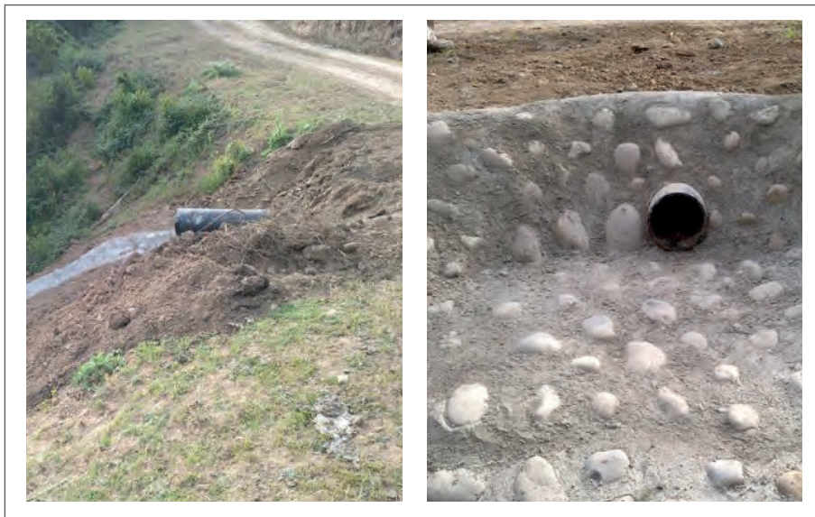
Figura 16. Obra de arte de atraveso de camino cercana al punto 7 del recorrido (Acta de inspección personal del Tribunal, fojas 835).
