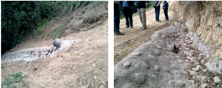
Figura 22: Obra de arte de atraveso de camino cercana al punto 7 del recorrido (Fuente: Acta de inspección personal del Tribunal, fojas 837).
