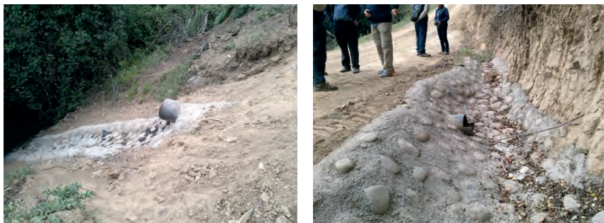
Figura 20. Obra de arte de atravesado de camino cercana al punto 2 del recorrido (Fuente: Acta de inspección personal del Tribunal, fojas 828).
