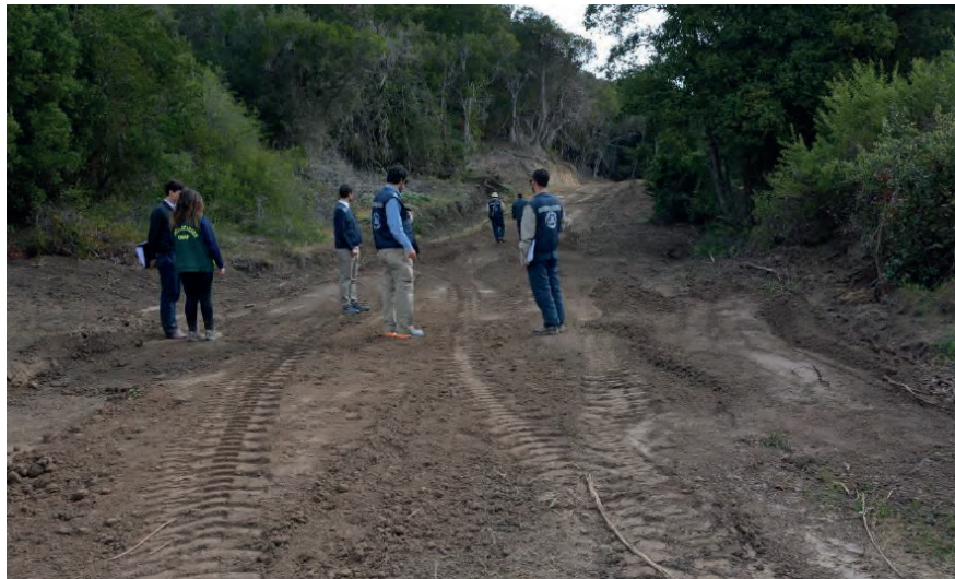
Figura 15. Vista general del camino en el punto N° 6° (Fuente: Acta de inspección personal del Tribunal, fojas 835).
