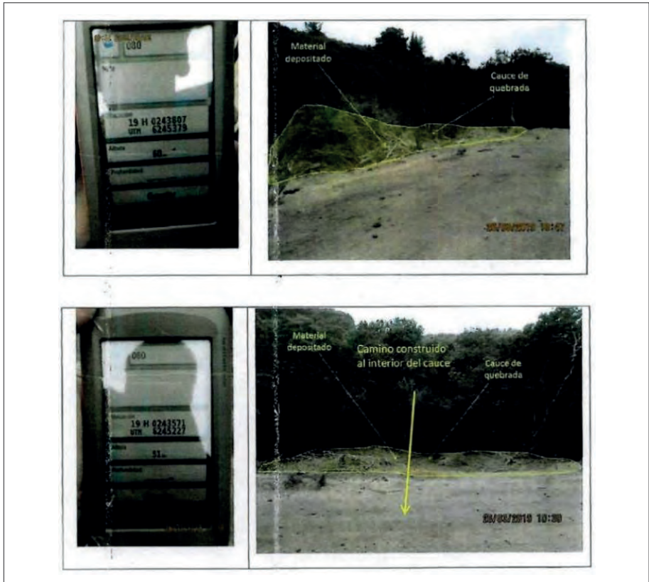
Figura 17. Registro fotográfico de 26 de marzo de 2019 (Fuente: Acta de Constatación de Hecho, oficio N° 171/2019, Dirección General de Aguas, fojas 175).
