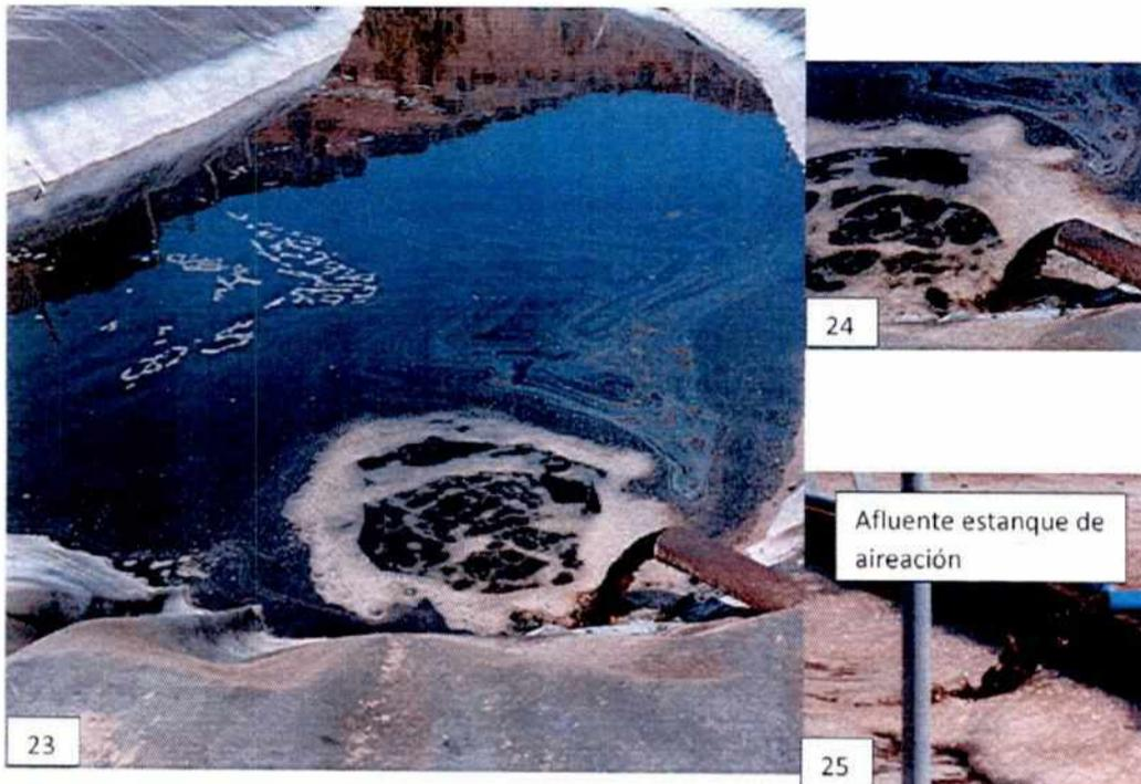
Fotos 22 y 23. Piscina impermeabilizada de acumulación de efluente secundario.
