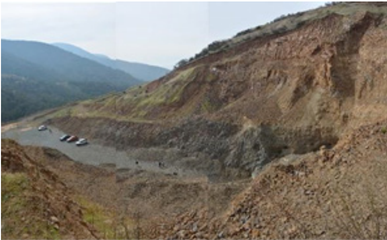
Fotografías N° 4 y 5: Cerro Panales. Descripción de los sectores de extracción de minerales, donde consta la remoción de masa en la ladera norte de dicho cerro y el pique minero ubicado a un costado de la misma ladera.
